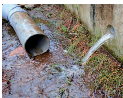
漏水が発生した農業用管路
