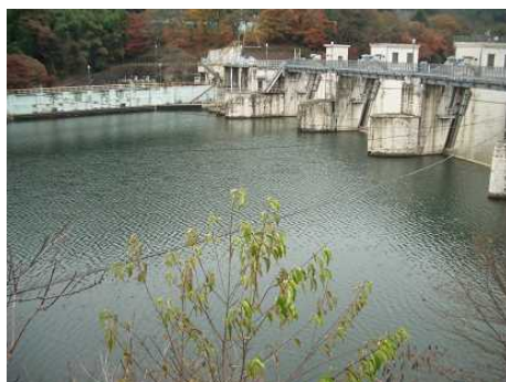
綾戸ダム(群馬用水取水口)
