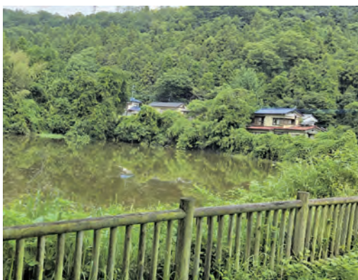
耐震工事が予定される石原貯水池(後堤)
